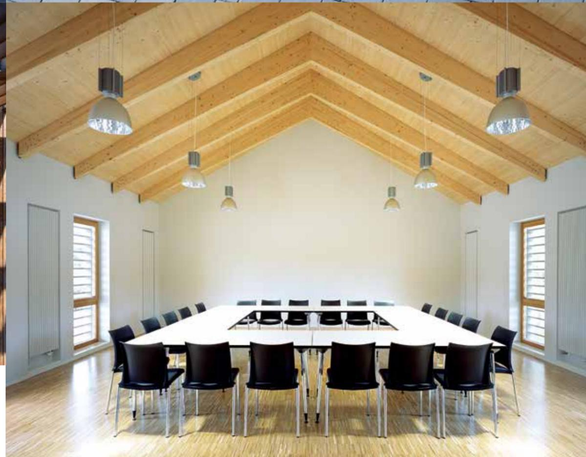
Durch die Verwendung eines Aufsparren-Dämmsystems auf einer Sichtschalung konnte das Tragwerk des gesamten Obergeschosses sichtbar bleiben. Der Dachstuhl wird zum prägenden Bestandteil der Versammlungsräume.
