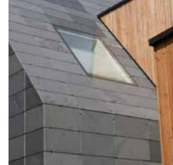
Die Dachfenster sind komplett flächeneben und im Raster montiert. Die Konstruktion für die flächenbündigen Dachfenster stammt aus dem Wintergartenbau. Die Fensterscheiben mit Aluminiumrahmen sind fest montiert und unbeweglich.
