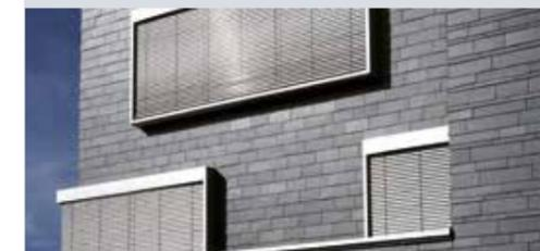
Weil große Fenster im Sommer auch einen größeren Klimatisierungsaufwand nach sich ziehen, wurden sie sorgfältig in die Dämmebene integriert und in Faschen mit vorgelagerten Sonnenschutzjalousien verbaut.
