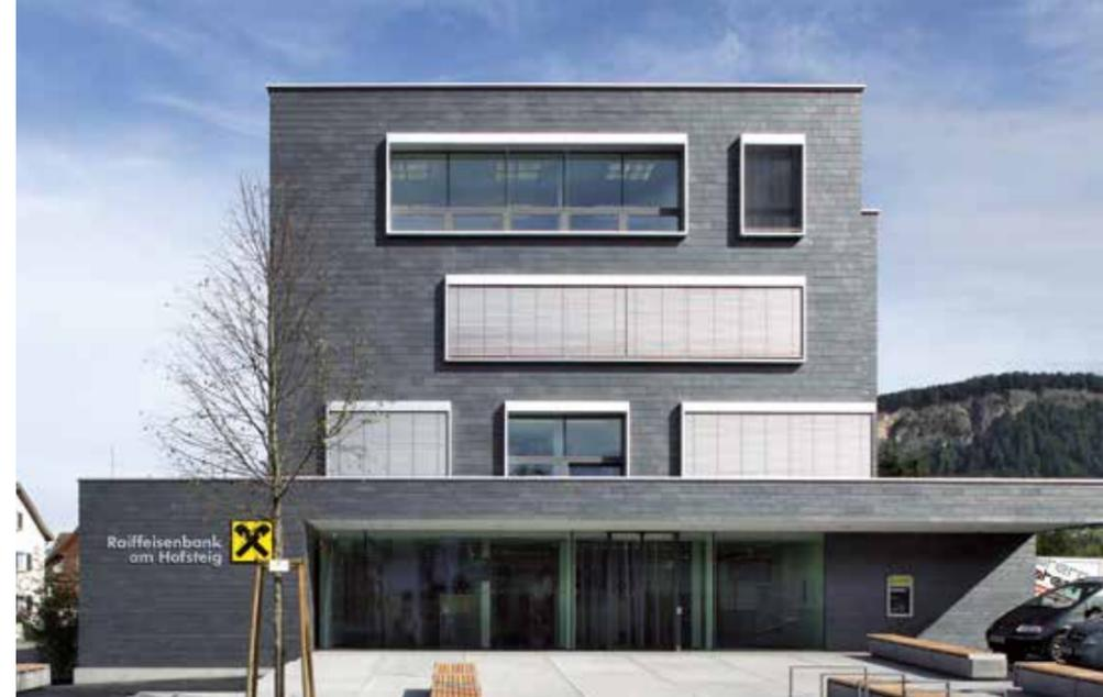
Die eingesetzten Steinlängen stammen aus dem Produktprogramm von Rathscheck Schiefer, so dass nur wenige Zurichtarbeiten vor Ort notwendig waren. Verbaut wurden Steine mit einer Länge von 30, 40, 50 und 60 cm. Die Schiefer wurden so verlegt, dass die Stoßfugen einen Versatz von mindestens 5 cm haben. Zur Hinterlegung der Stoßfugen dienen 10 cm breite, schwarz lackierte Aluminiumstreifen.
