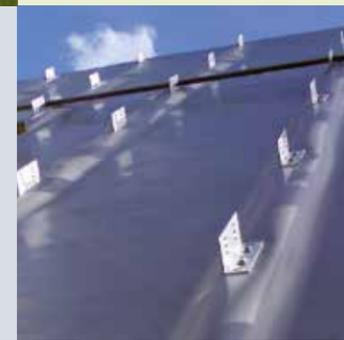
Die Halterungen für die Aluminium-Unterkonstruktion der Schieferdeckung sind auf den Konterlattungen montiert und damit aus der Wasserführung genommen.
