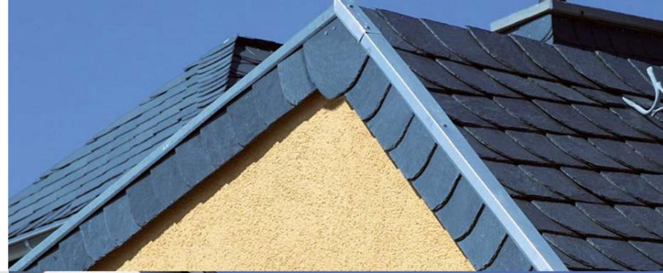
*Der Ortgang eines Daches wird häufig mit Schiefer bekleidet. Er schützt die Dachkonstruktion langfristig an dieser empfindlichen Stelle.*
