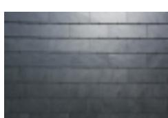
Fassadenfläche mit säurefestem Schiefer, Qualität InterSIN® (in den Codestufen W1, S1, T1), in Horizontaler Deckung mit 45 mm Höhenüberdeckung unter Verwendung von 2 Stück Edelstahl-Spezialhaken (blank bzw. brüniert) pro Stein eindecken. Die Edelstahl-Spezialhaken werden auf der Tragelattung (mind. 30x50 mm) verschraubt. Die Schiefereindeckung erfolgt im halben Verband mit Stoßfuge.
